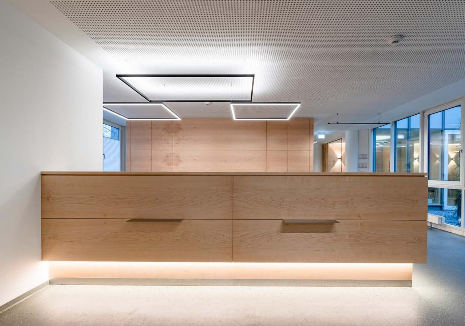
*Abb.: Die Empfangstheke wird durch zwei unterschiedlich große rechteckige Leuchten betont. Die beiden kleineren Leuchten sorgen mit ihrem direkten Lichtanteil für homogenes Arbeitslicht, das größere Lichtrechteck erhellt mit indirektem Licht die weiße Decke.*
